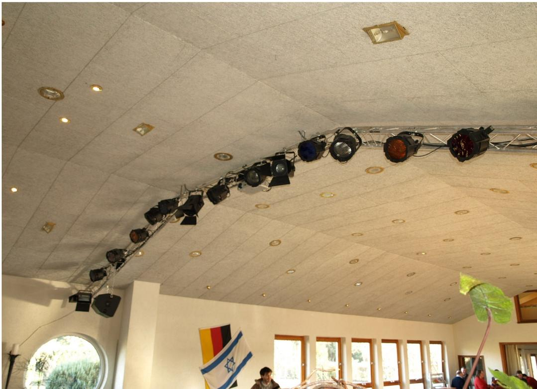
Praktischer Einbau des Beamers auf der Lichttraverse. Gewinkeltes Dach aus Akustikplatten verhindert starke Reflektionen.
