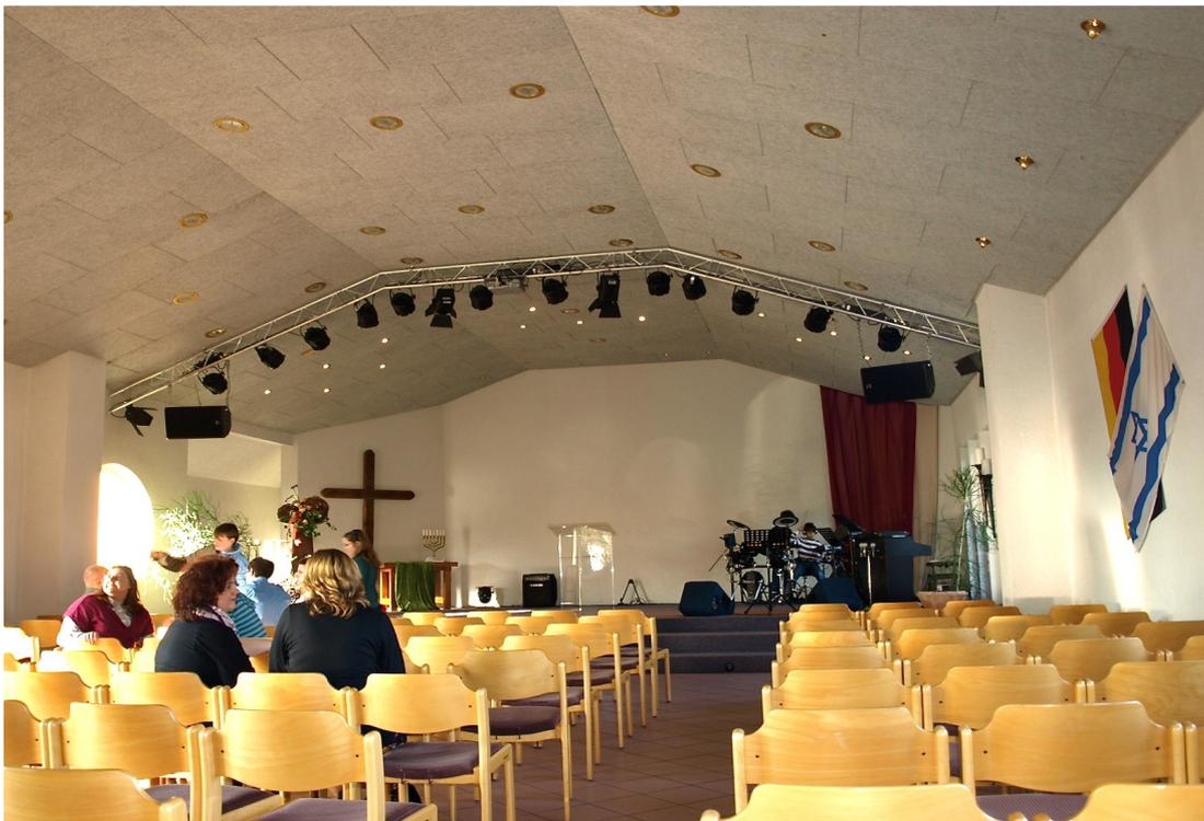
Gewinkelte Dachkonstruktion mit Akustikplatten, gut für die Akustik und eine Traverse über die voller Breite als praktische Halterungsmöglichkeit für Boxen, Scheinwerfer und Beamer.
