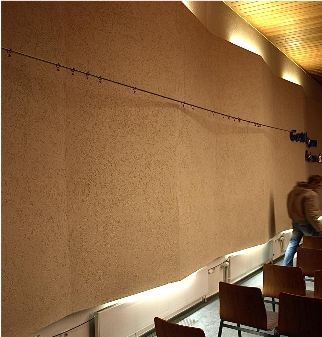
Eine optimale Lösung – Rauputz auf einer gewinkelten Wandfläche hilft Reflektionen zu absorbieren und zerstreuen, und gleichzeitig eine indirekte Beleuchtung dahinter verstecken.
