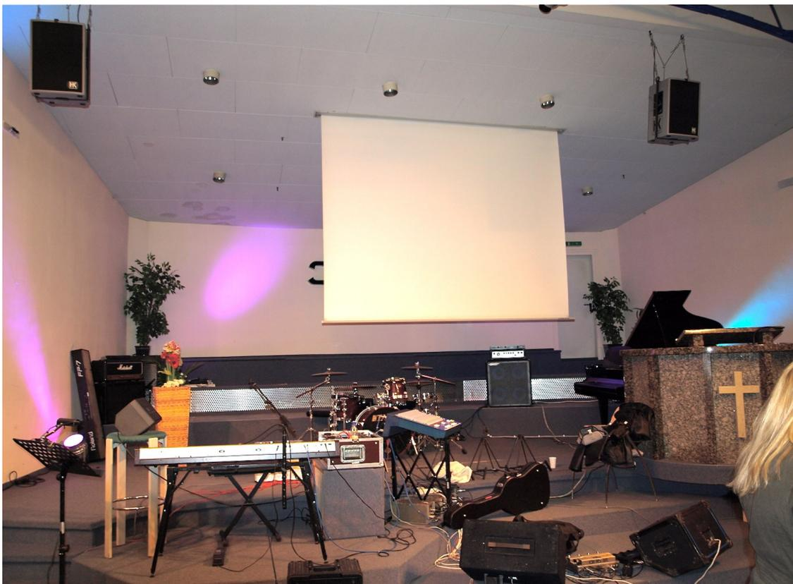
Hier ist die Leinwand zu weit vorne und beschränkt die Bühnenflexibilität. Die Boxen sind zu weit hinten und somit hinter Mikros. Auch die Platzierung eines Subwoofers unten auf derselben vertikalen Linie ist jetzt fast unmöglich. Es bleibt nur die Möglichkeit es auf Ketten „fliegen“ zu lassen
